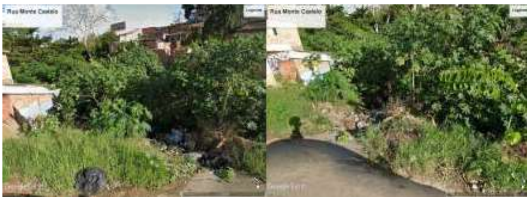
Figura 03: Áreas de risco de deslizamento. Fonte: Google Earth, 2023.
